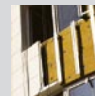
Вентилируемый фасад МЕТАКОМ величина воздушного зазора — 75 мм, с учетом глубины панели — 105 мм по пожарной опасности относится к классу К0 (непожароопасные)
